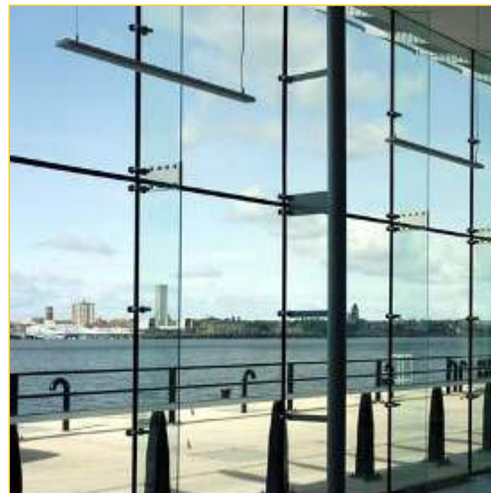
سیستم اسپایدر که در آن از ستون های شیشه ای استفاده شده است
